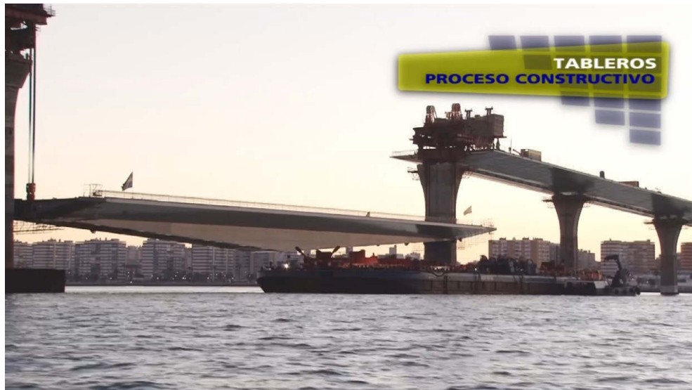
Traslado, izado y montaje del puente desmontable
