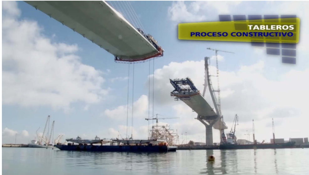
Cierre del vano central del puente
