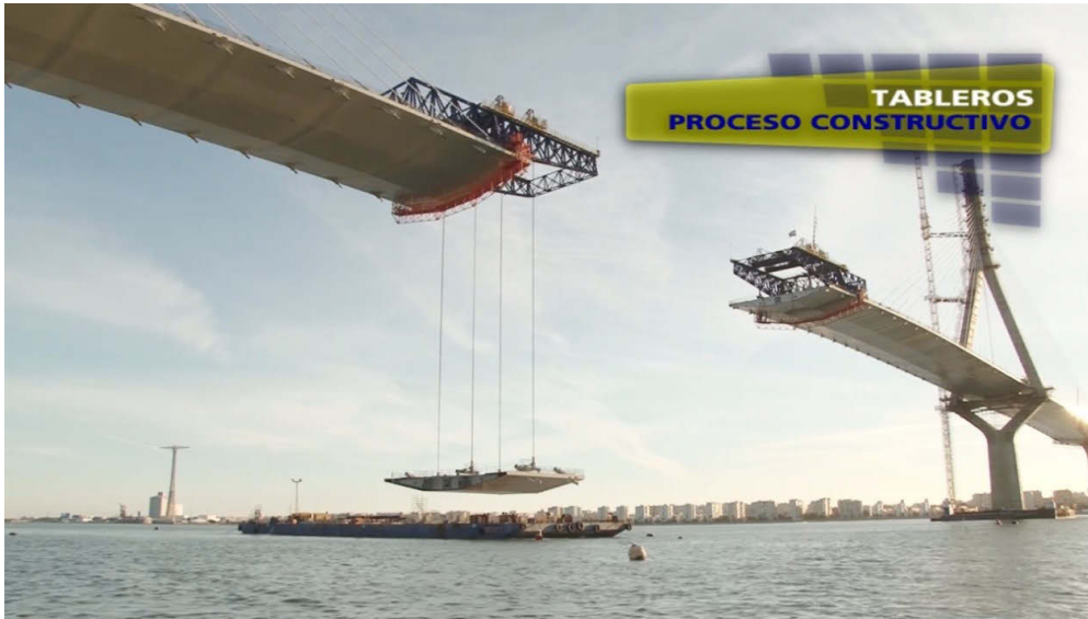
Traslado de dovelas en pontona ("load out") e izado para montaje.
