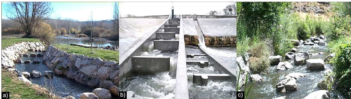
Figura 2. Dispositivos de paso. a) Río artificial de vertederos sucesivos. b) Escala de estanques sucesivos. c) Río artificial de bloques
