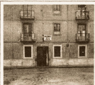
Cuartel de la Guardia Civil, en Salinas, frente al cual, fue muerto el sargento por los sublevados
