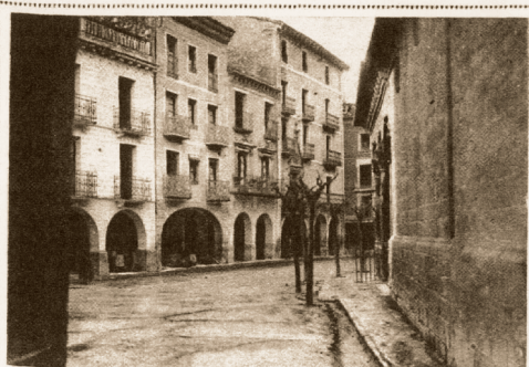
Lugar en que comenzó la sublevación de Jaca y ocurrieron los primeros sucesos, martirizado el sargento de la Guardia Civil
