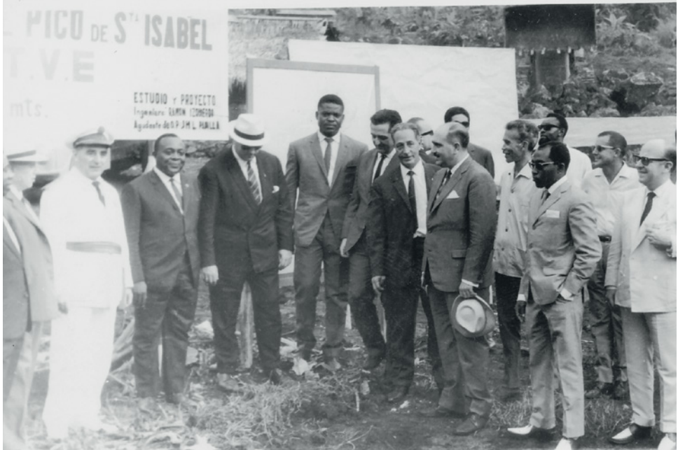
La construcción de la carretera de El Pico, Manuel Fraga en 1968. A su derecha, el tercero es Ramón Izquierdo, ingeniero director; dos puestos más allá, José María López Padilla, ayudante de obras públicas.
