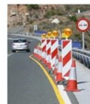
Llums grocs fixos o intermitents (sobre balises de vora provisionals)
