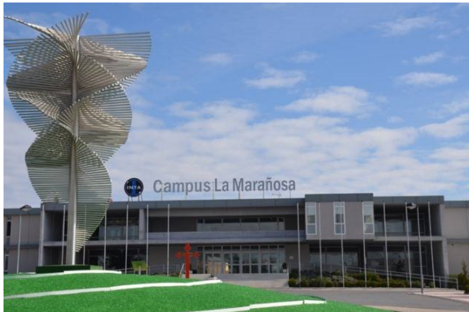
Figura 7: Vista frontal del edificio
