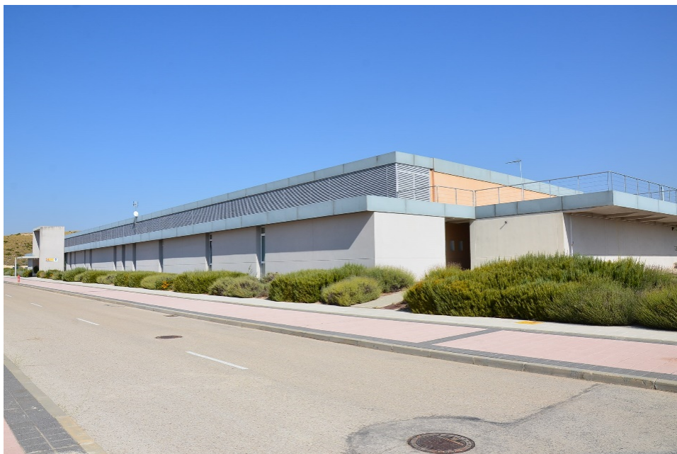
Figura 5: Vista frontal del Campus E6 del INTA de La Marañosa
